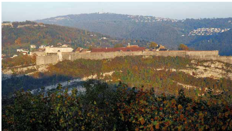
fig. Fig. 11 La topographie exceptionnelle du site de Besançon inspira Vauban. © JC Duverget.
