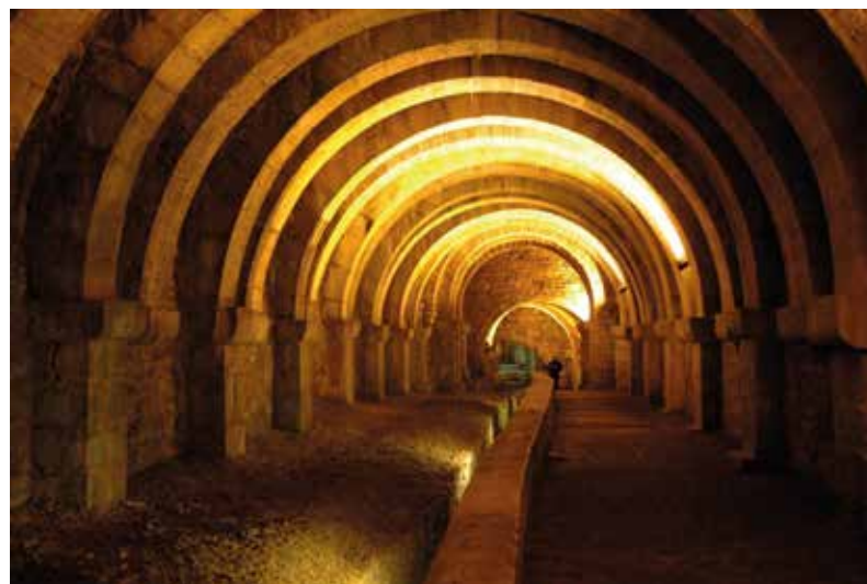
Fig. 9. La Grande Saline de Salins-les-Bains, la galerie souterraine du XIII e siècle. © JC Duverget.
